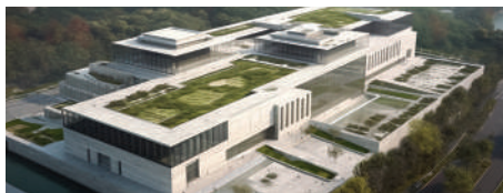
Indonesia 20MW Data Center Bekasi, Jakarta
